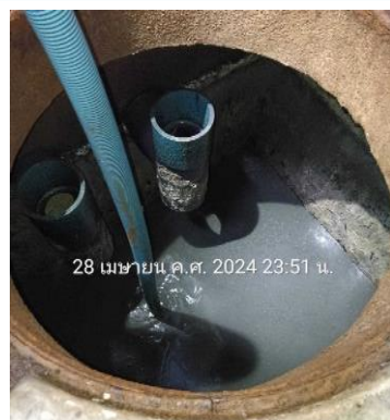
รูปที่ 3-16 การสูบลากตะกอน
