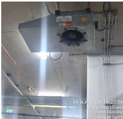
รูปที่ 3-7 พัดลมระบายอากาศบริเวณพื้นที่จอดรถ
