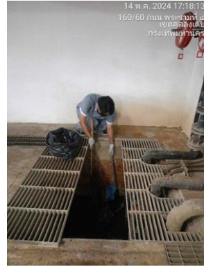
รูปที่ 3-73 ทำความสะอาดท่อน้ำทิ้ง
