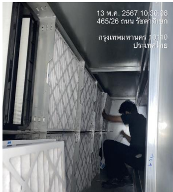
รูปที่ 3-41 การทำความสะอาดแผ่นกรองอากาศ
